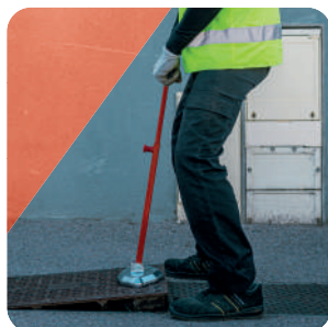
ÉTAPE 2 Aimer au bord, lever légèrement et tirer en faisant glisser la plaque au sol
